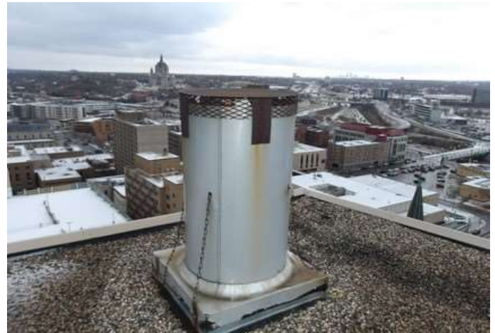
Trash chute vent
