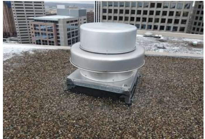
Downblast exhaust fan
