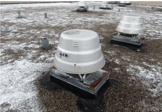
Downblast exhaust fan
